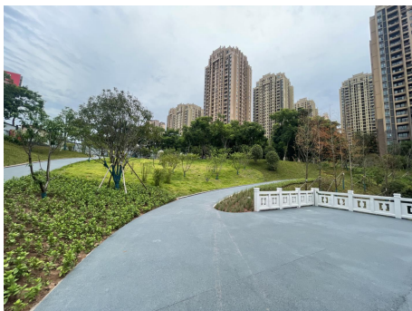
堰坪水库库尾临时占地恢复
